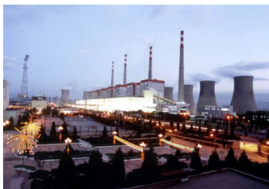
Centrale bioénergétique du district de Shan
